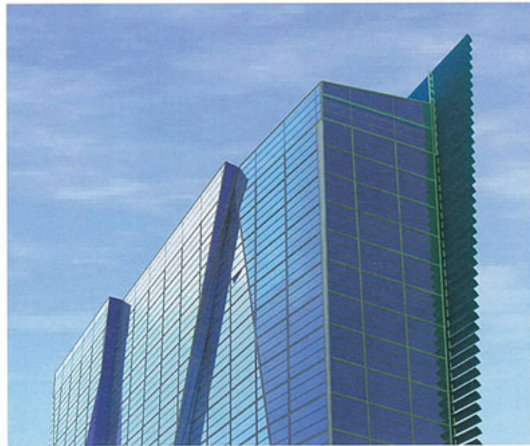
Programma di recupero urbano in zona Magliana, L'albergo, dettaglio di facciata
